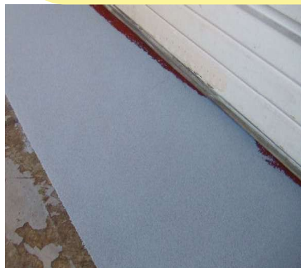
出入口の段差の補修 スロープの作成も簡単
