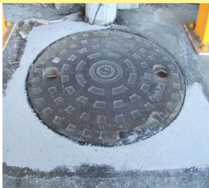
マンホール廻りの補修
