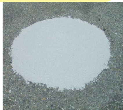
大きなエグレの補修 床に穴があると、とても危険です
