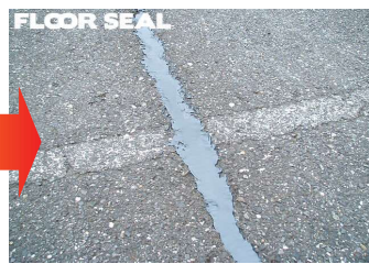
⑥ これで目地の補修は終了です
