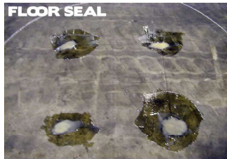
機械やラックを撤去した後の アンカー跡の補修
