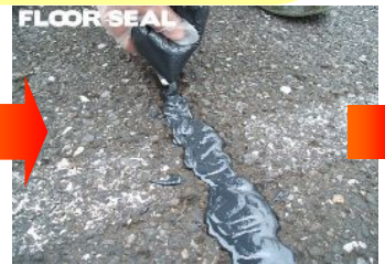
④ しぼり出しながらかき付けする場所に適量を流します
