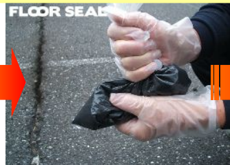
② 補修箇所を掃除した後、主剤と硬化剤を混合します
