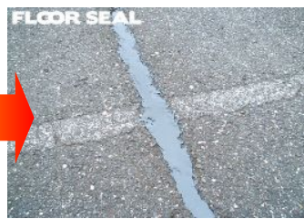
⑥ これで目地の補修は終了です
