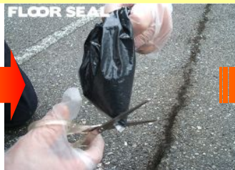
③ 混合した材料の袋の角をハサミ等で三角に切り取ります
