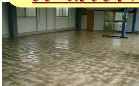
自動車整備工場 塗布例
