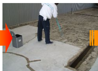
ファーストプライマーを 全面にローラーで塗布
