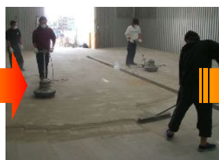
ワイヤーブラシ等で 表面のレイタンスを除去して 掃除します
