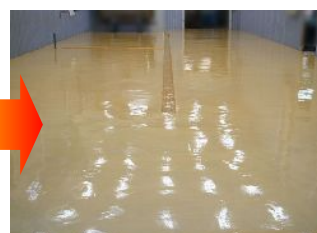
プライマーが硬化(乾燥)したら、 シリカフロアーを施工します
